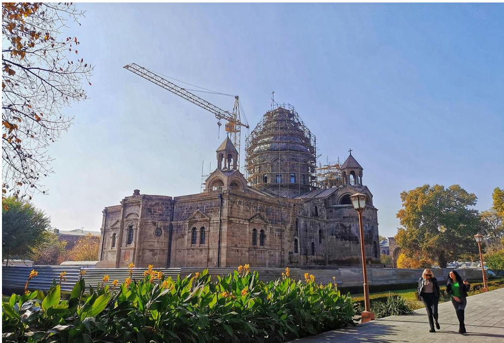
Figure 18 : Cathédrale Saint-Jean de la Mère de Dieu à Stepanakert pendant sa construction en 2019. Bougie de Jérusalem (s.d.).
