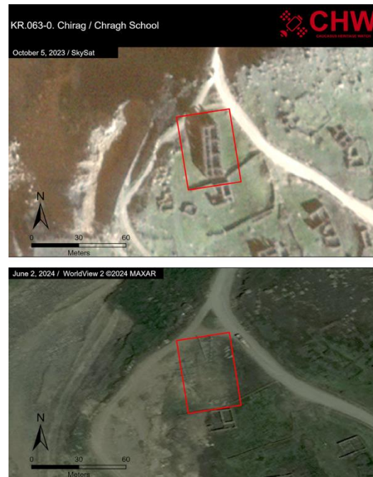
Figure 12.2: Les vestiges de l'école de Chirag le 5 octobre 2023 (en haut) et la destruction de l'école le 2 juin 2024 (en bas). Caucasus Heritage Watch (2024).
